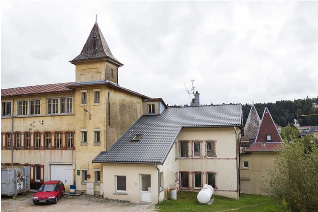
Atelier : façade nord.
