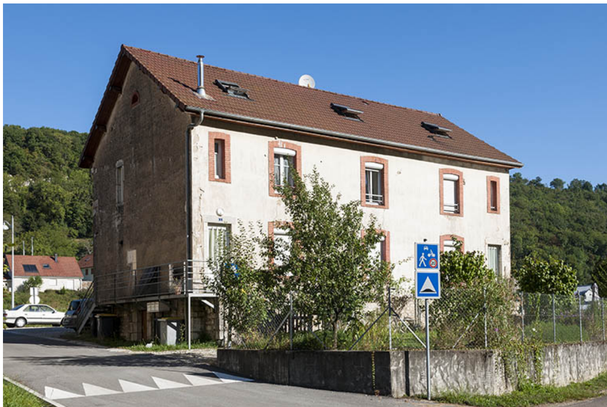
Logement ouvrier (sud) à 4 appartements. Façade est.
