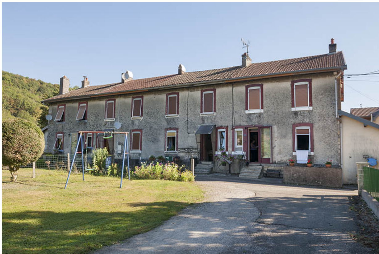
Logement ouvrier (8 appartements). Vue depuis le nord.
