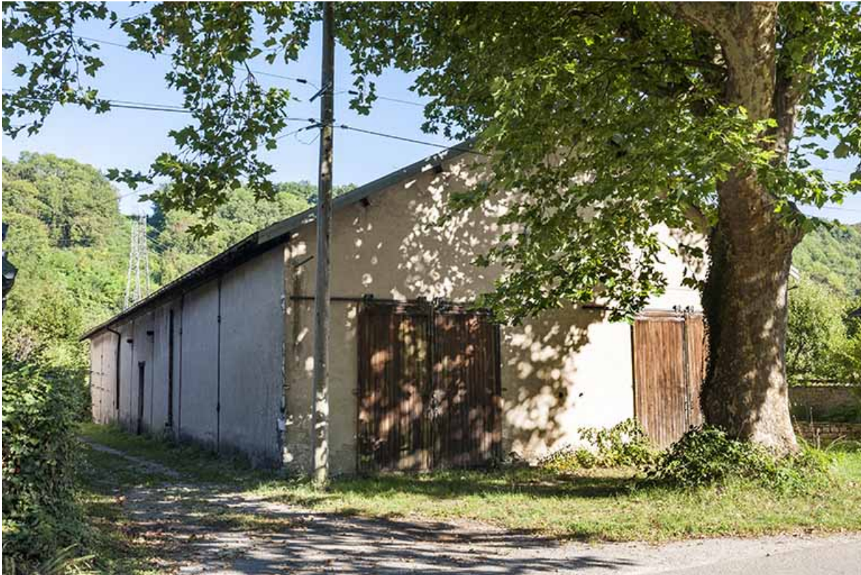
Magasin industriel vu depuis la route.
