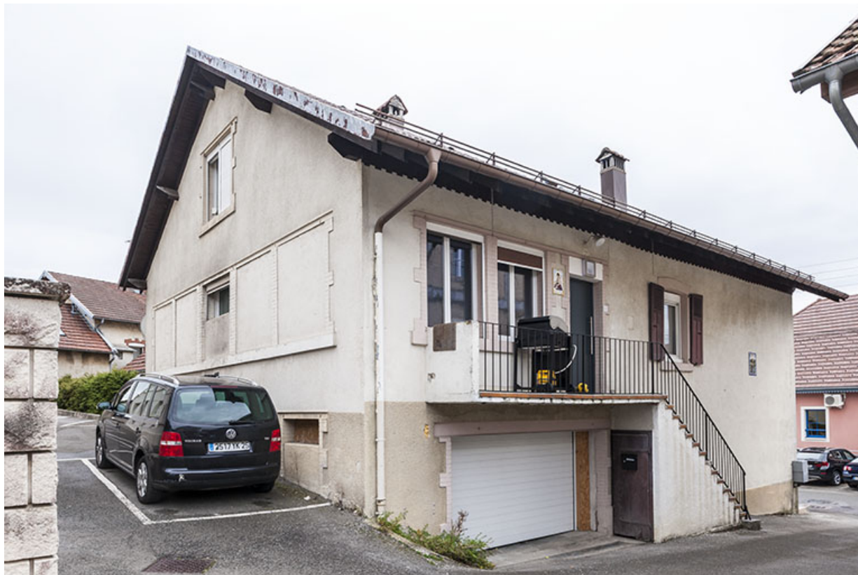
Maison : façades postérieure et latérale gauche.
