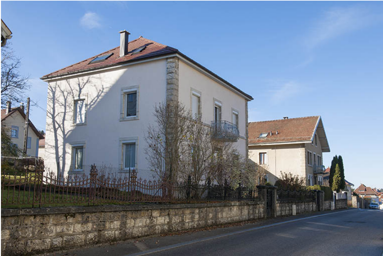
Vue d'ensemble du site, depuis l'est.
