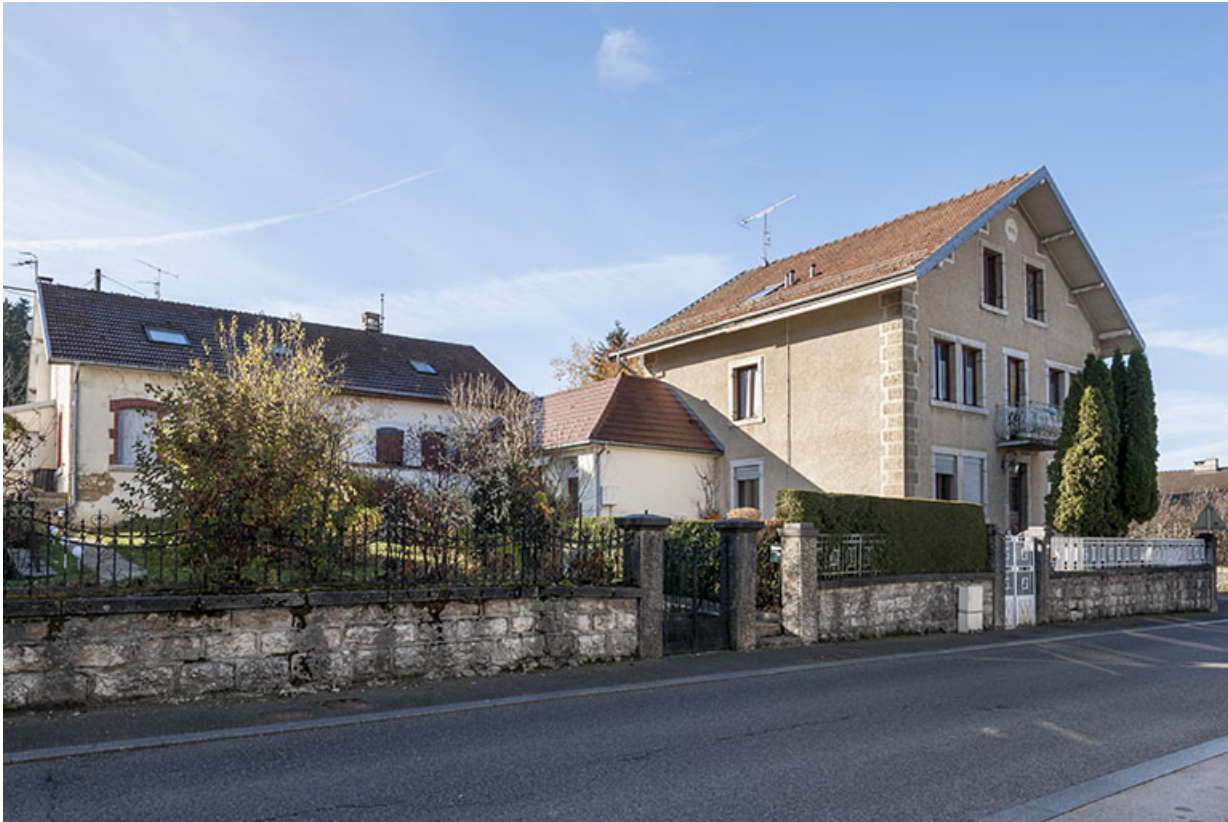
Maison au n° 14 et atelier de fabrication.
