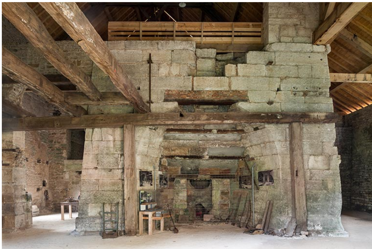
Haut fourneau, vu de face.
