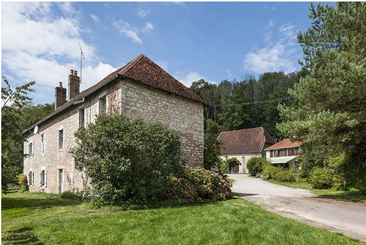
Vue d'ensemble depuis l'entrée du site.
