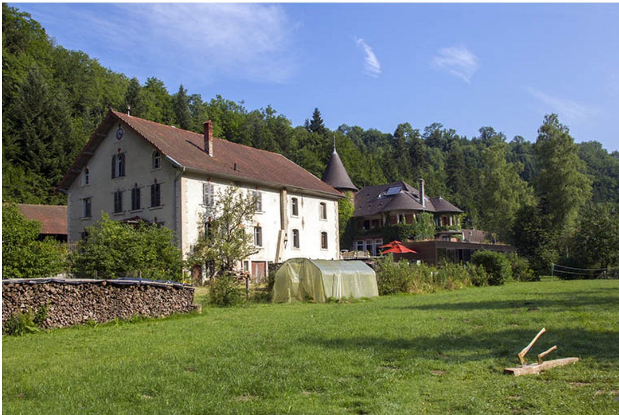
Vue d'ensemble du site, depuis le sud-est.
