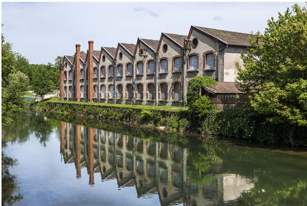
Façade ouest de l'atelier de fabrication.
