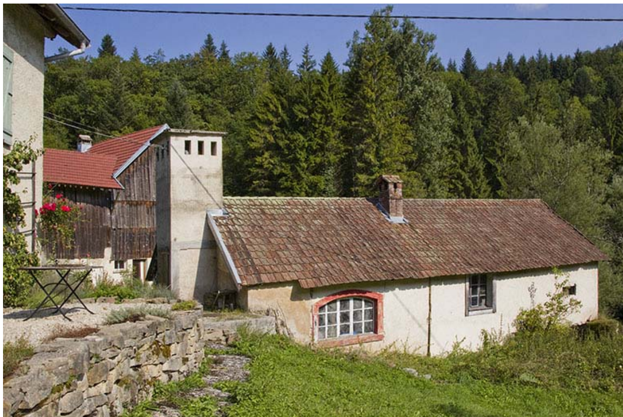
Centrale : façade postérieure, de trois quarts gauche.
