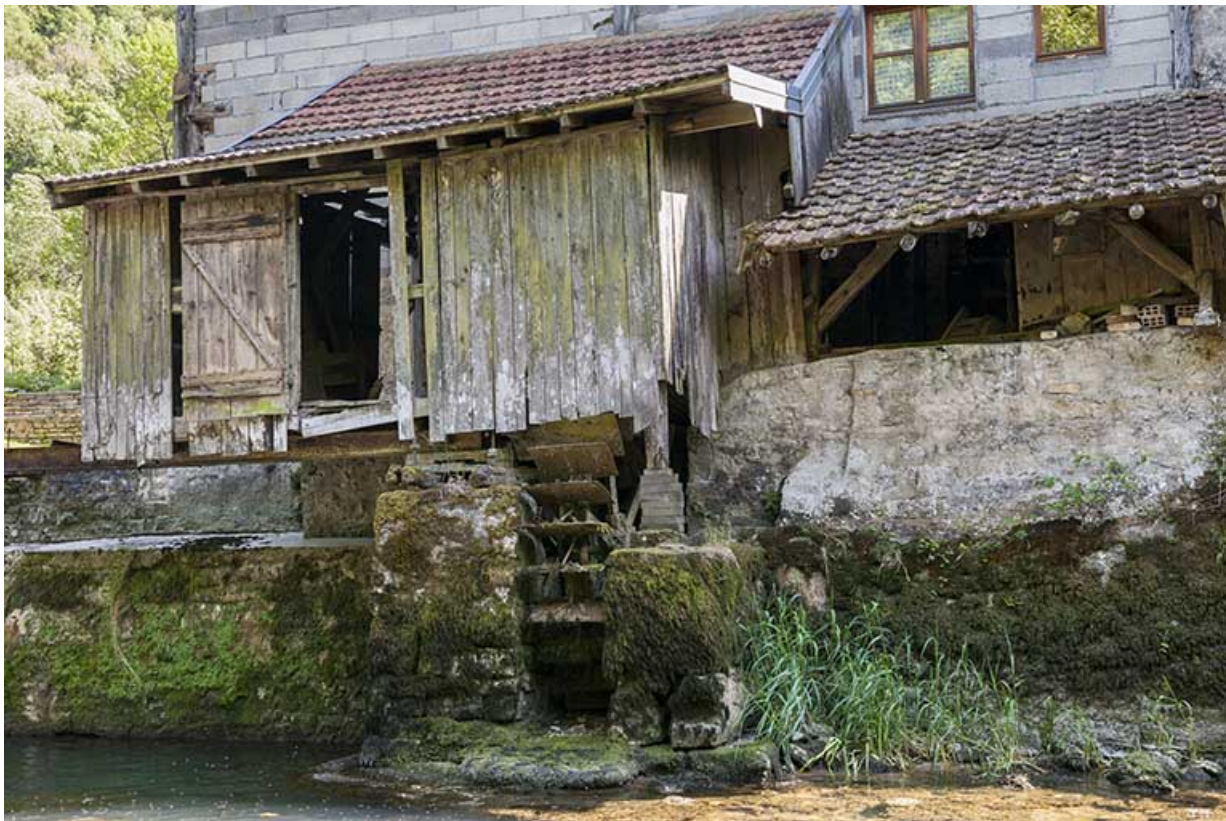
Façade nord. Le bâtiment d'eau.
