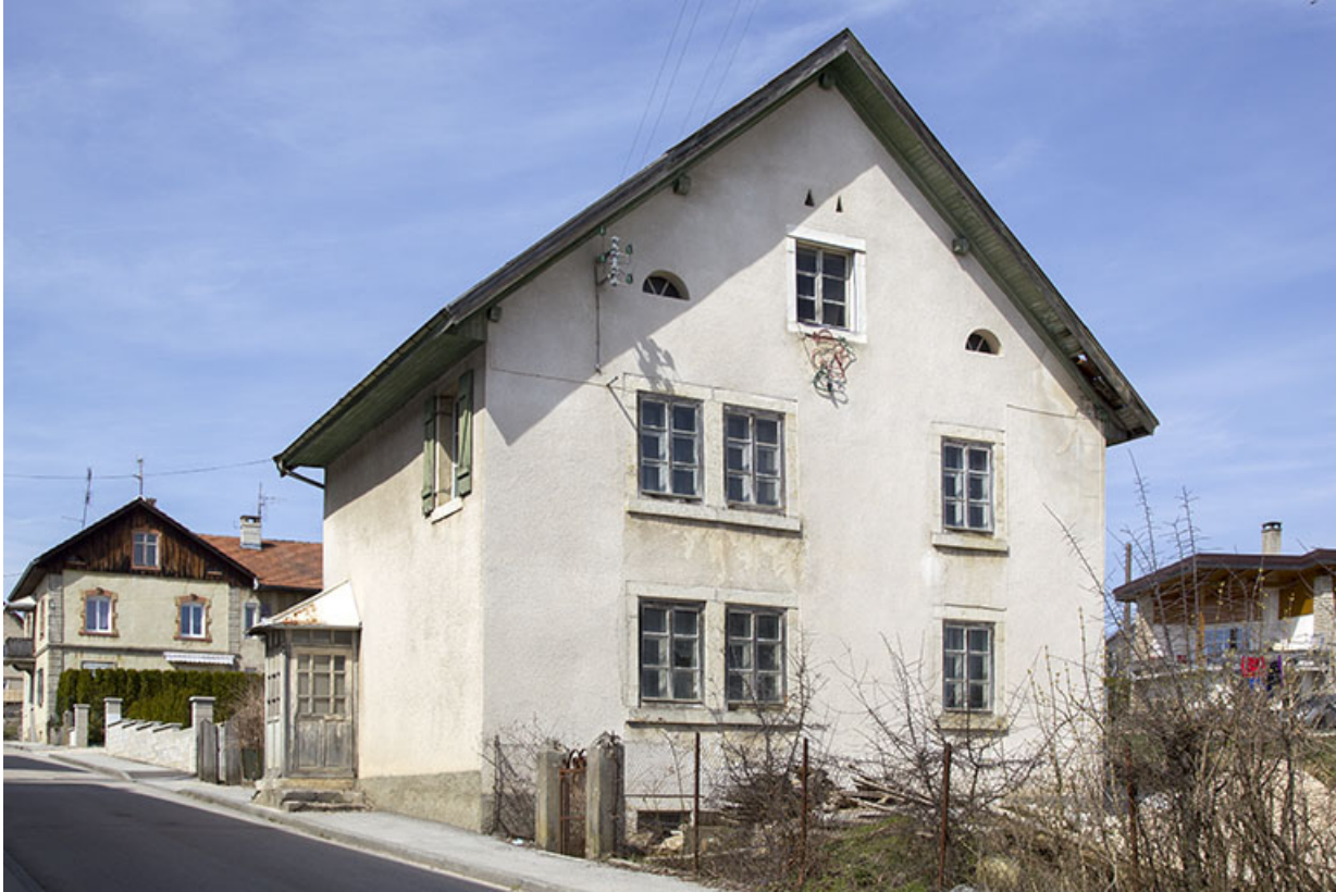
Façades antérieure et latérale droite.
