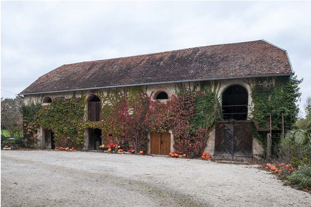
Façade est du bâtiment à fonction agricole.
