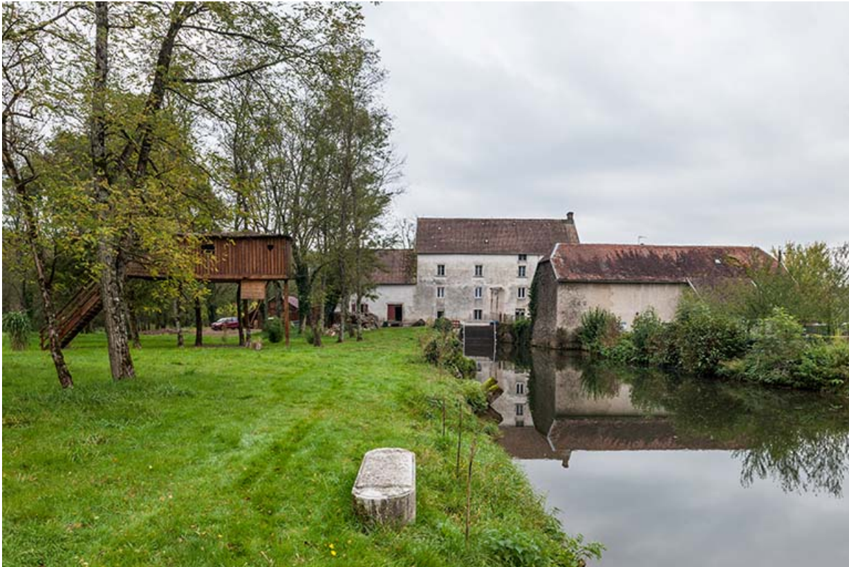
Vue d'ensemble depuis le bief d'aménée.
