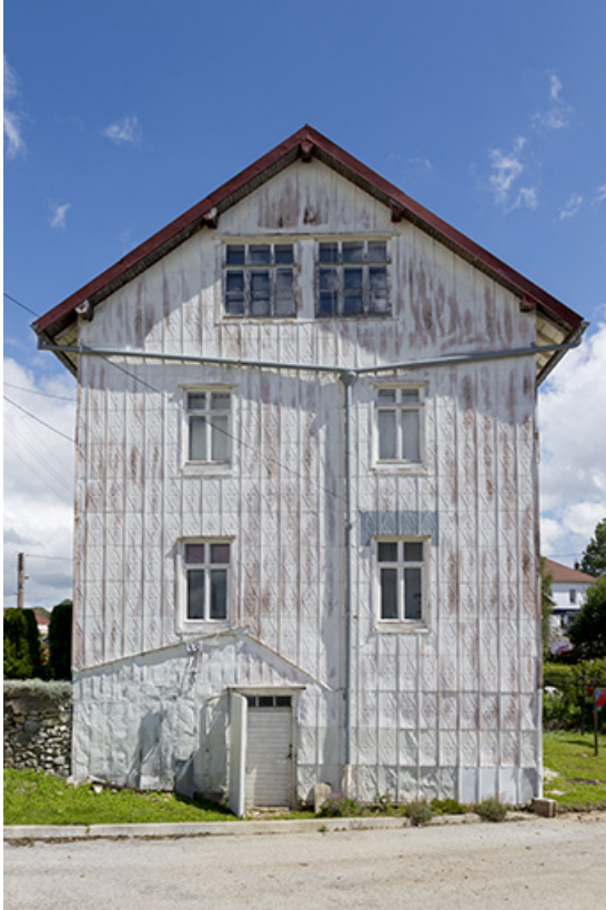
Façade latérale droite.
