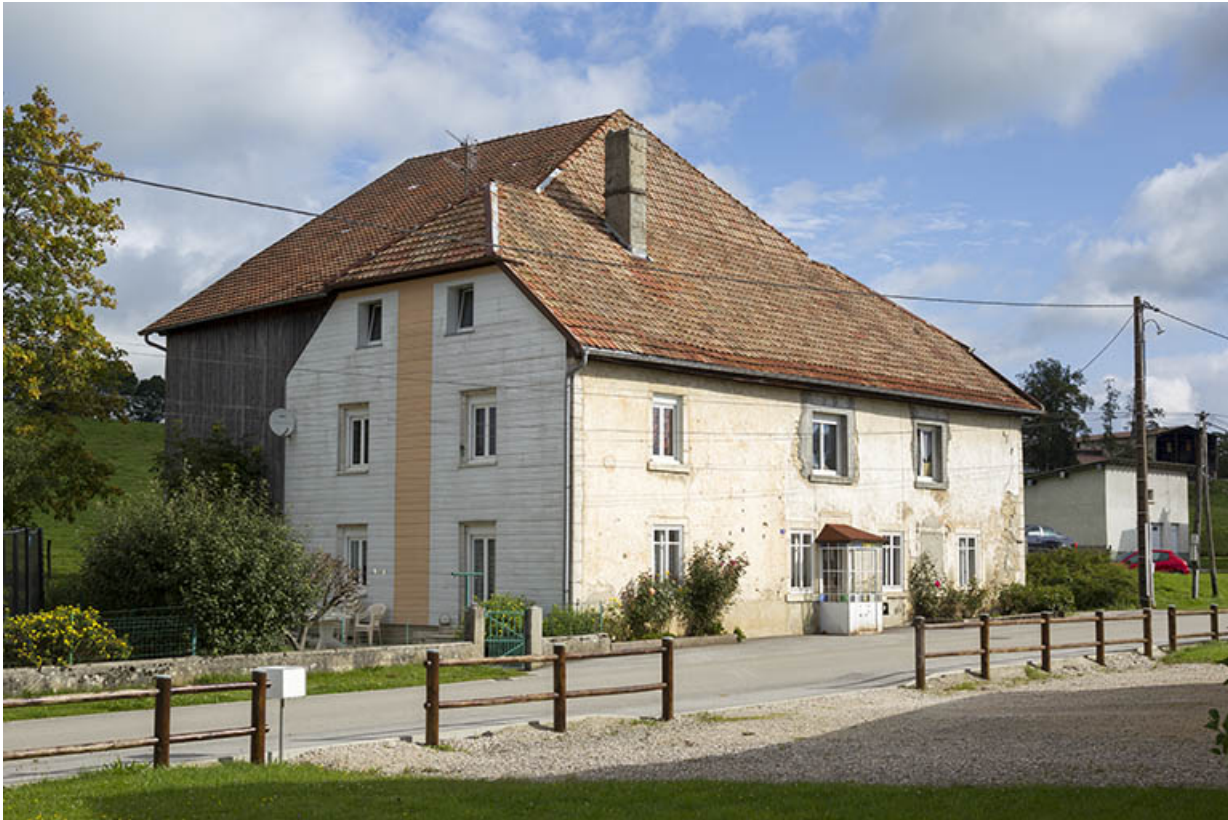
Façades antérieure et latérale gauche.
