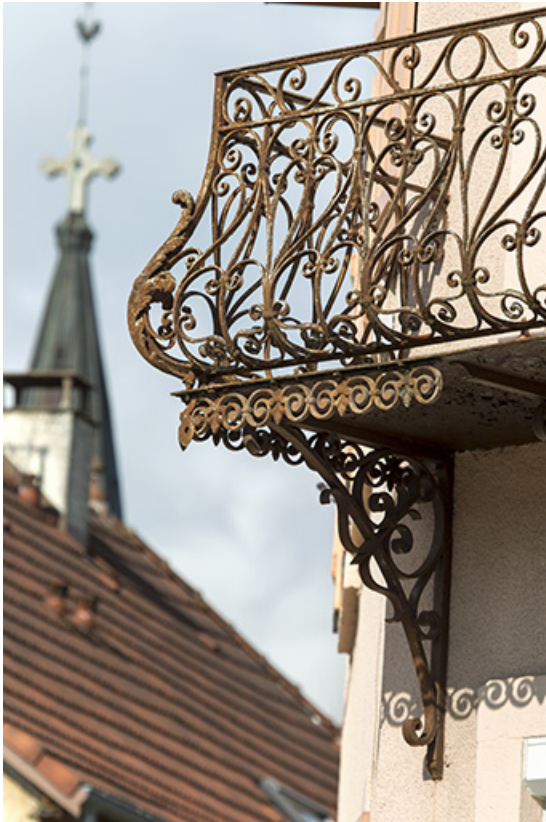
Balcon sur le pan coupé (détail).
