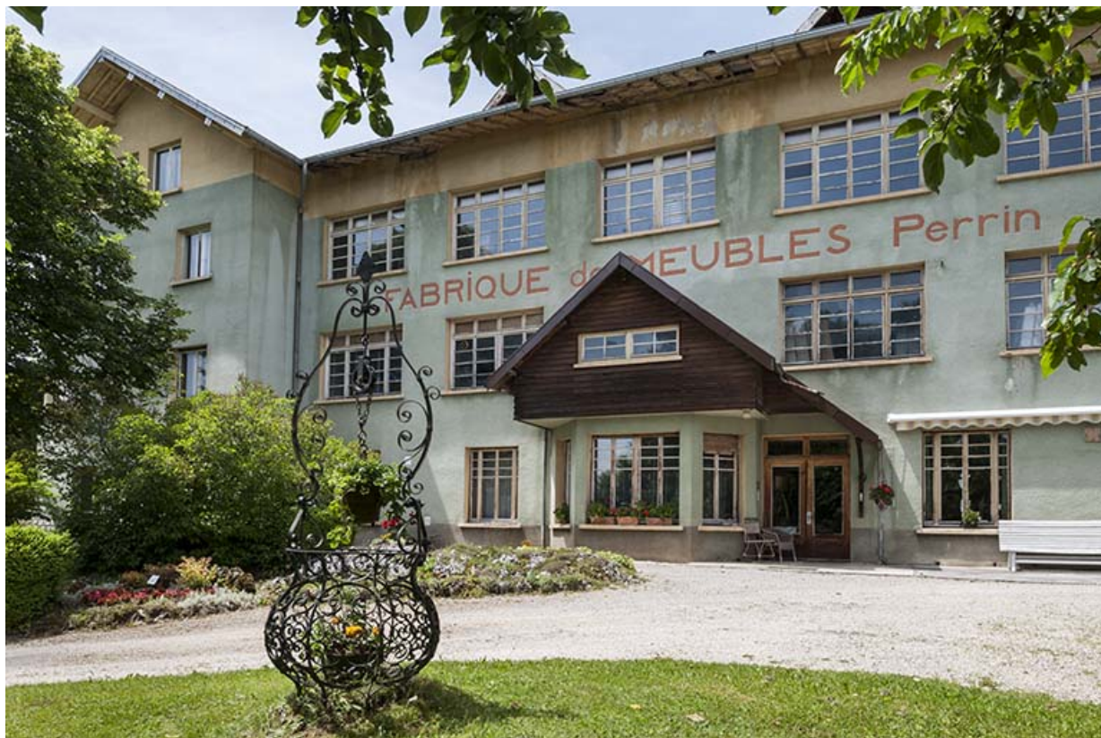
Atelier de menuiserie. Façade est.
