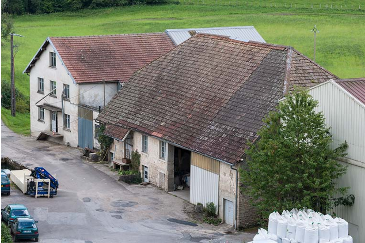
Vue plongeante sur les bâtiments du moulin.
