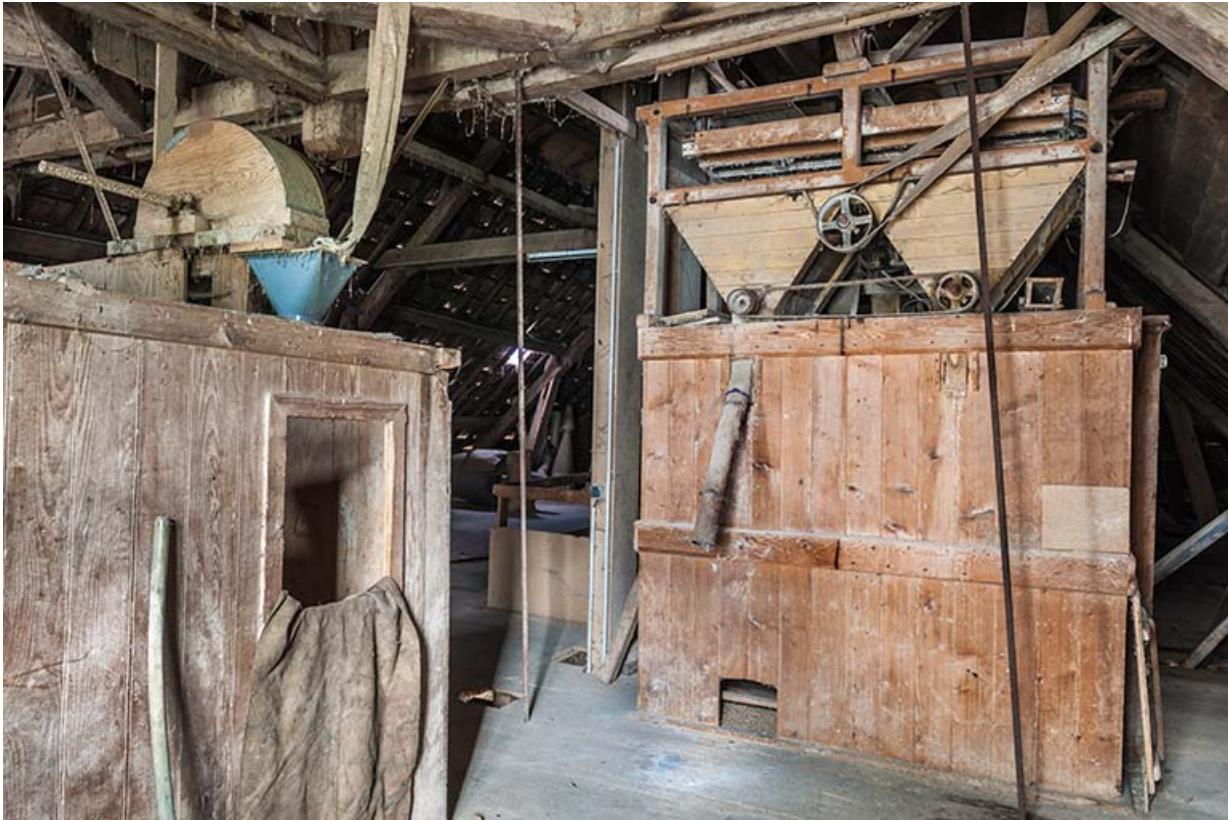
Etage de comble. Chambres à grains.
