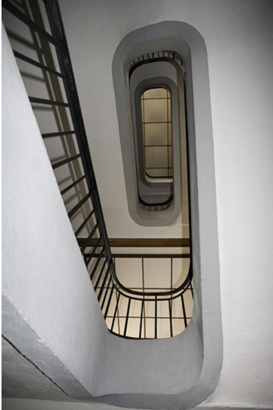
Corps d'entrée : escalier vu en contre-plongée.
