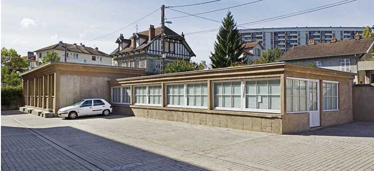
Garages : façades antérieure et latérale droite.
