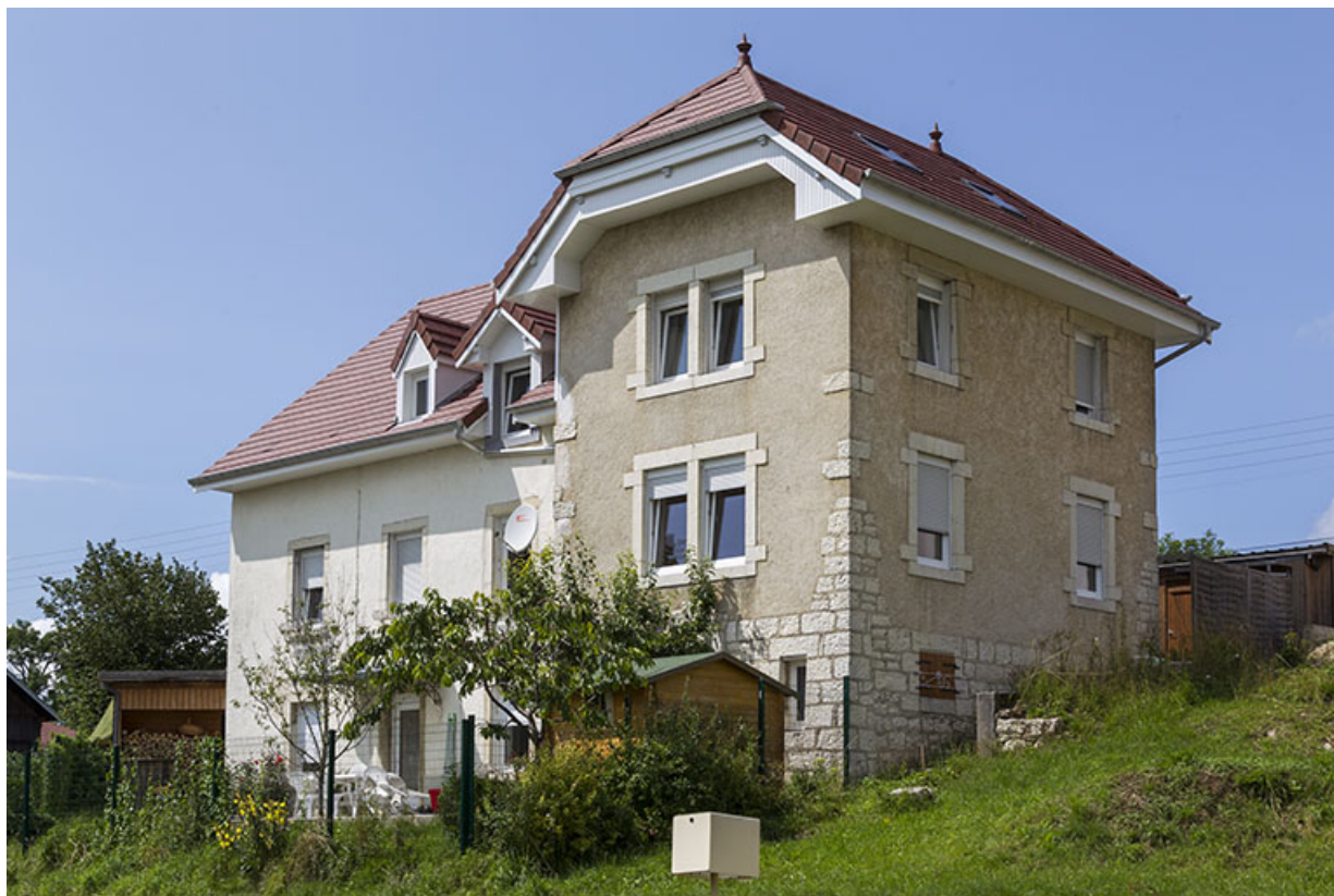
Façades postérieure et latérale gauche.
