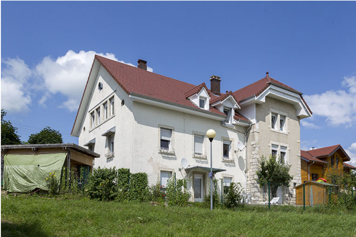
Façades postérieure et latérale droite.
