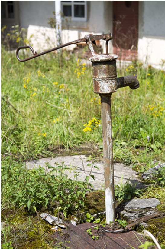
Pompe à eau sur la citerne.
