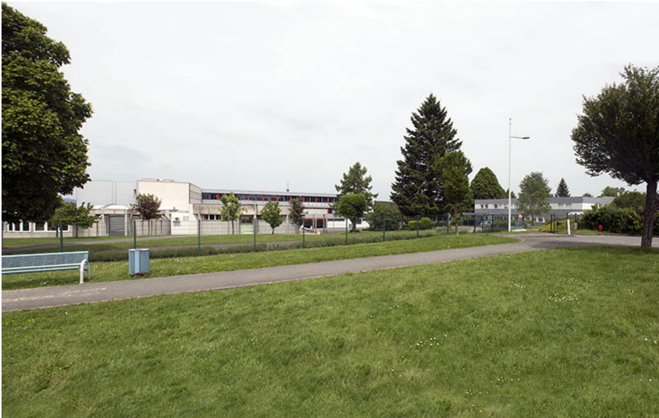
Vue d'ensemble depuis la placette au sud.
