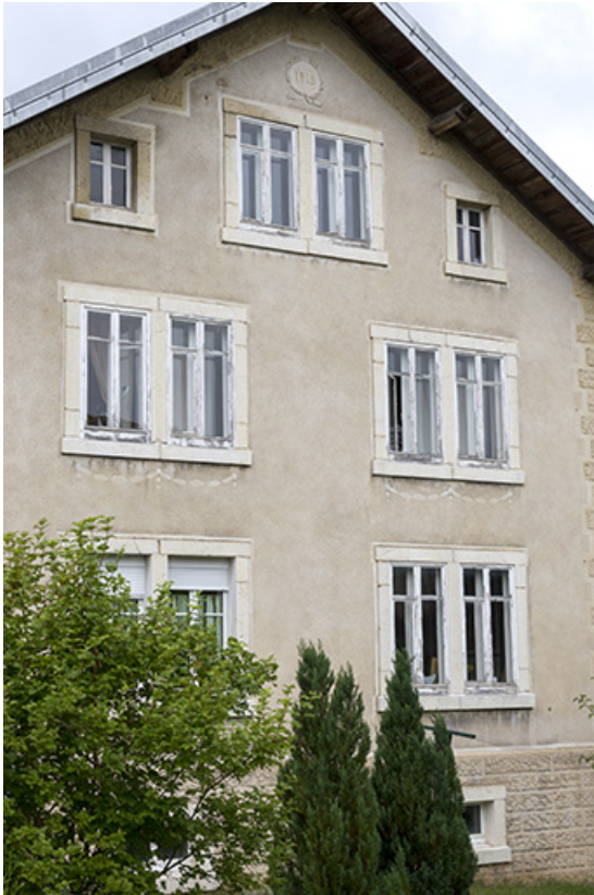
Façade latérale droite, de trois quarts gauche.
