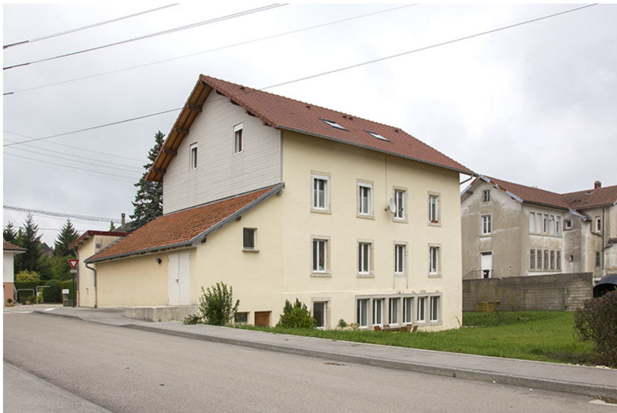
Façades postérieure et latérale gauche.
