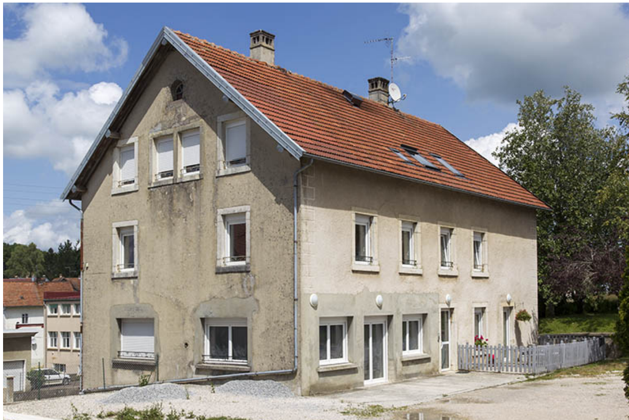
Façades postérieure et latérale droite.
