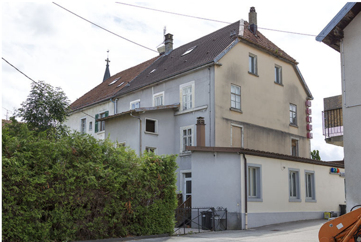
Façades postérieure et latérale gauche.
