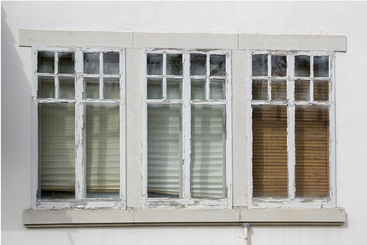
Façade latérale droite : fenêtres multiples.
