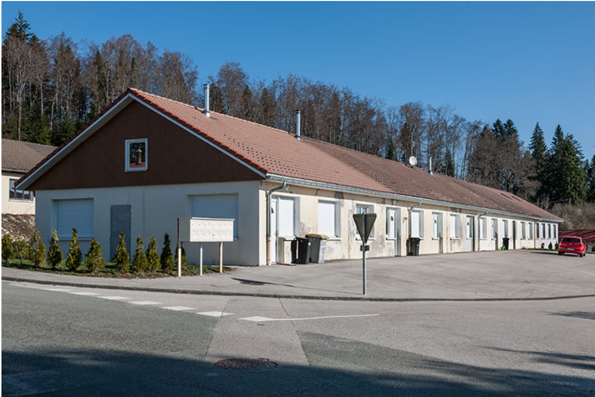
Vue d'ensemble, depuis le sud.
