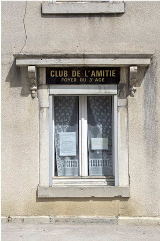
Logement patronal : fenêtre sur la façade antérieure.
