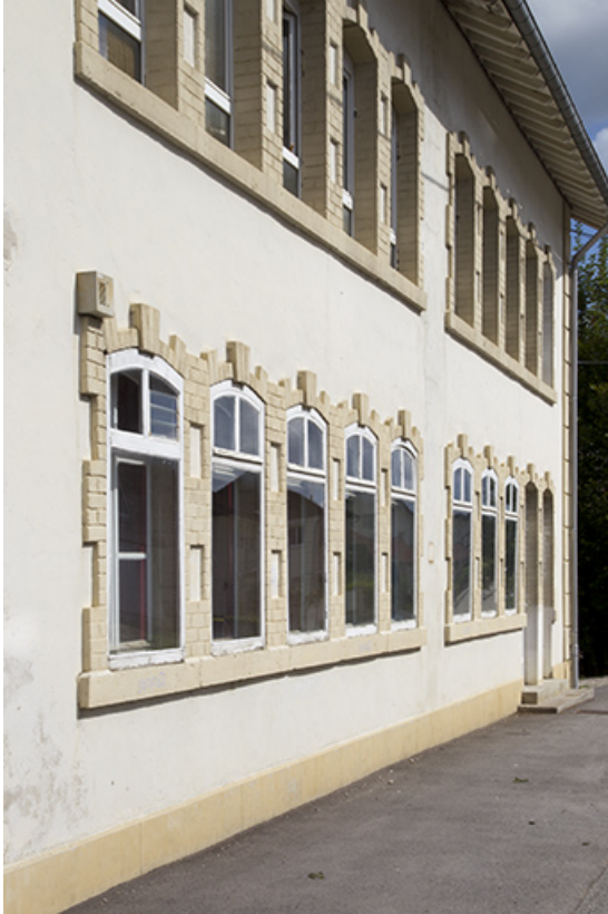
Façade antérieure : fenêtres multiples vues en enfilade.
