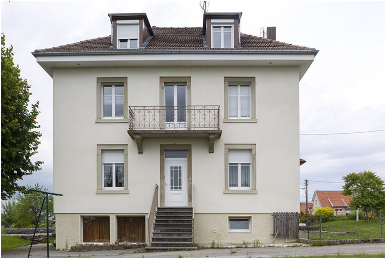
Logement patronal : façade latérale droite.
