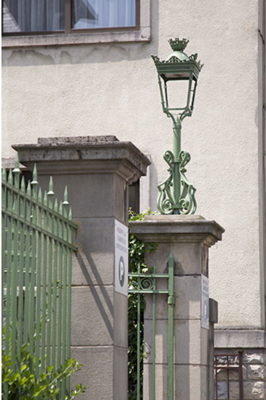
Portail : piliers, grille et luminaire.
