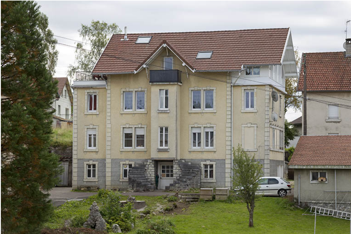
Maison : façade postérieure.
