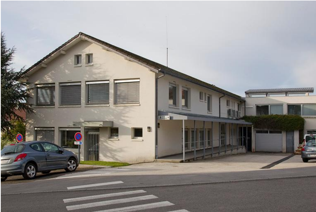
Bâtiment d'origine : façades latérale droite et postérieure.
