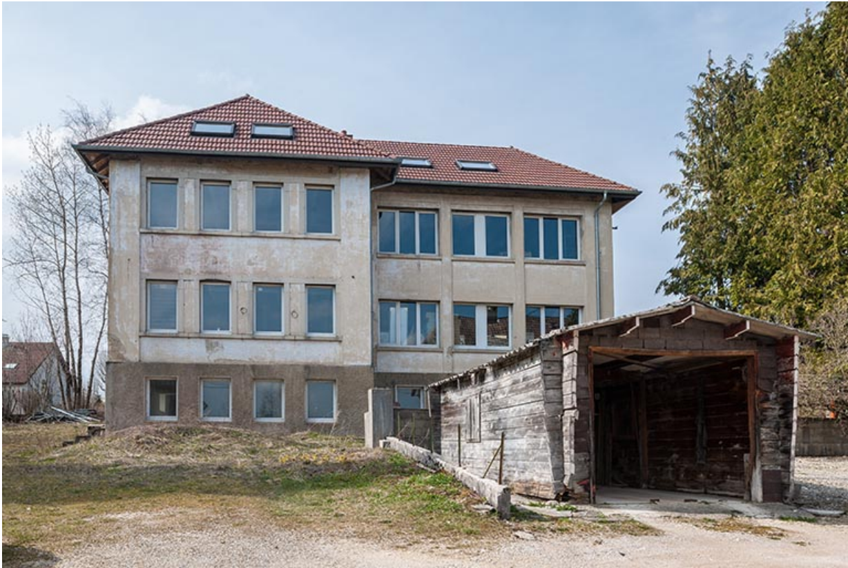
Usine : façade antérieure.
