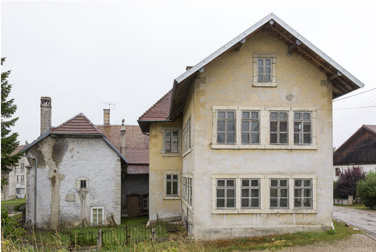
Usine : façade latérale gauche.
