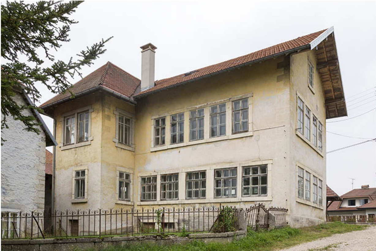
Usine : façades postérieure et latérale gauche.
