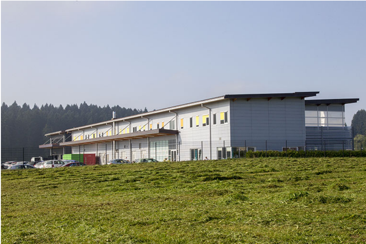
Façades antérieure et latérale droite.
