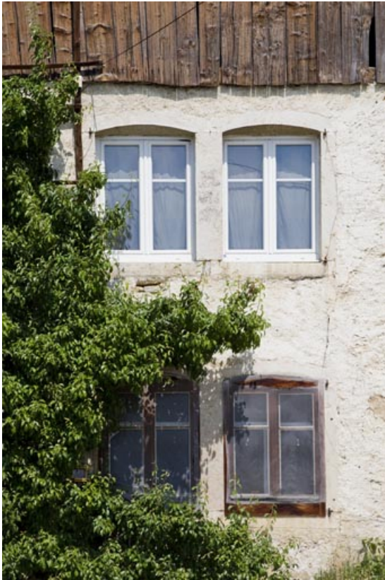
Travée de fenêtres doubles en façade.
