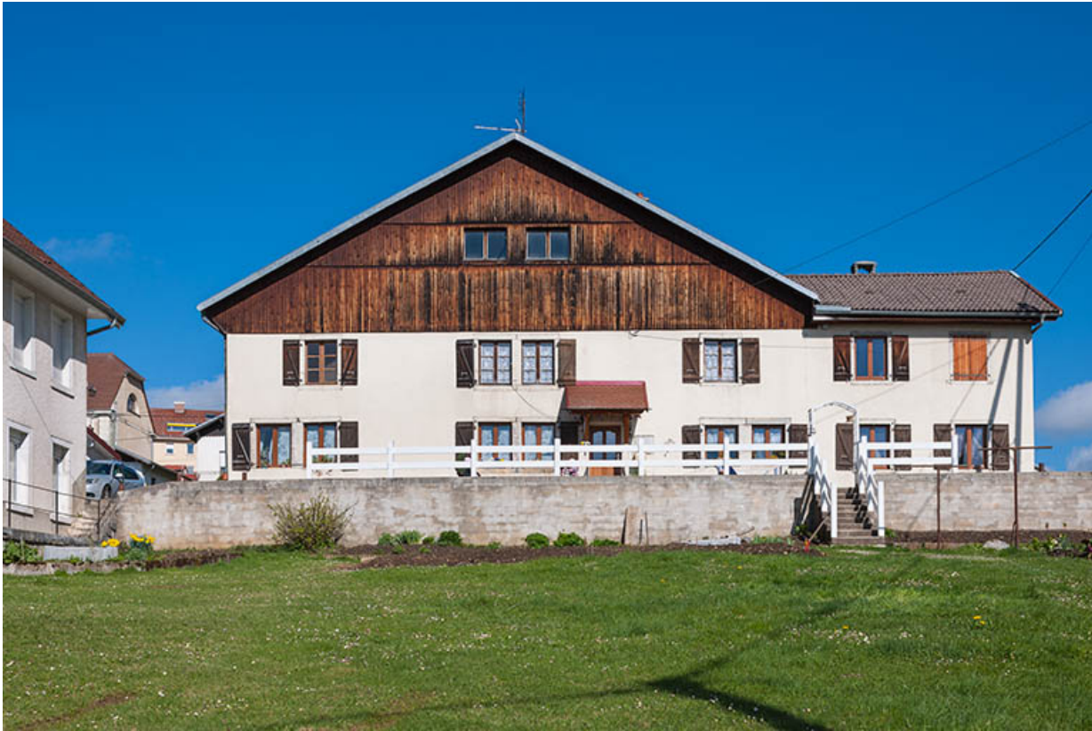
Ferme : façade antérieure.
