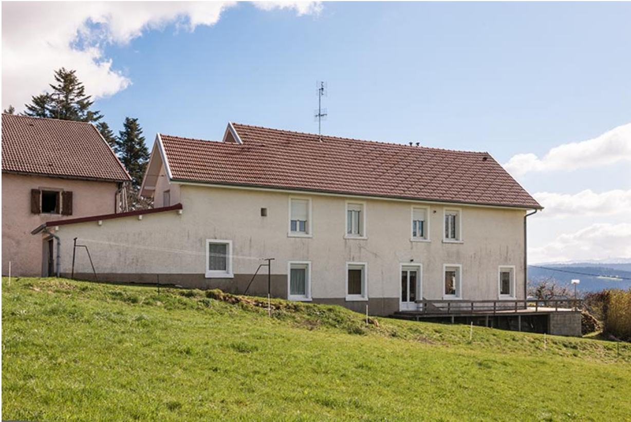
Atelier : façade postérieure.
