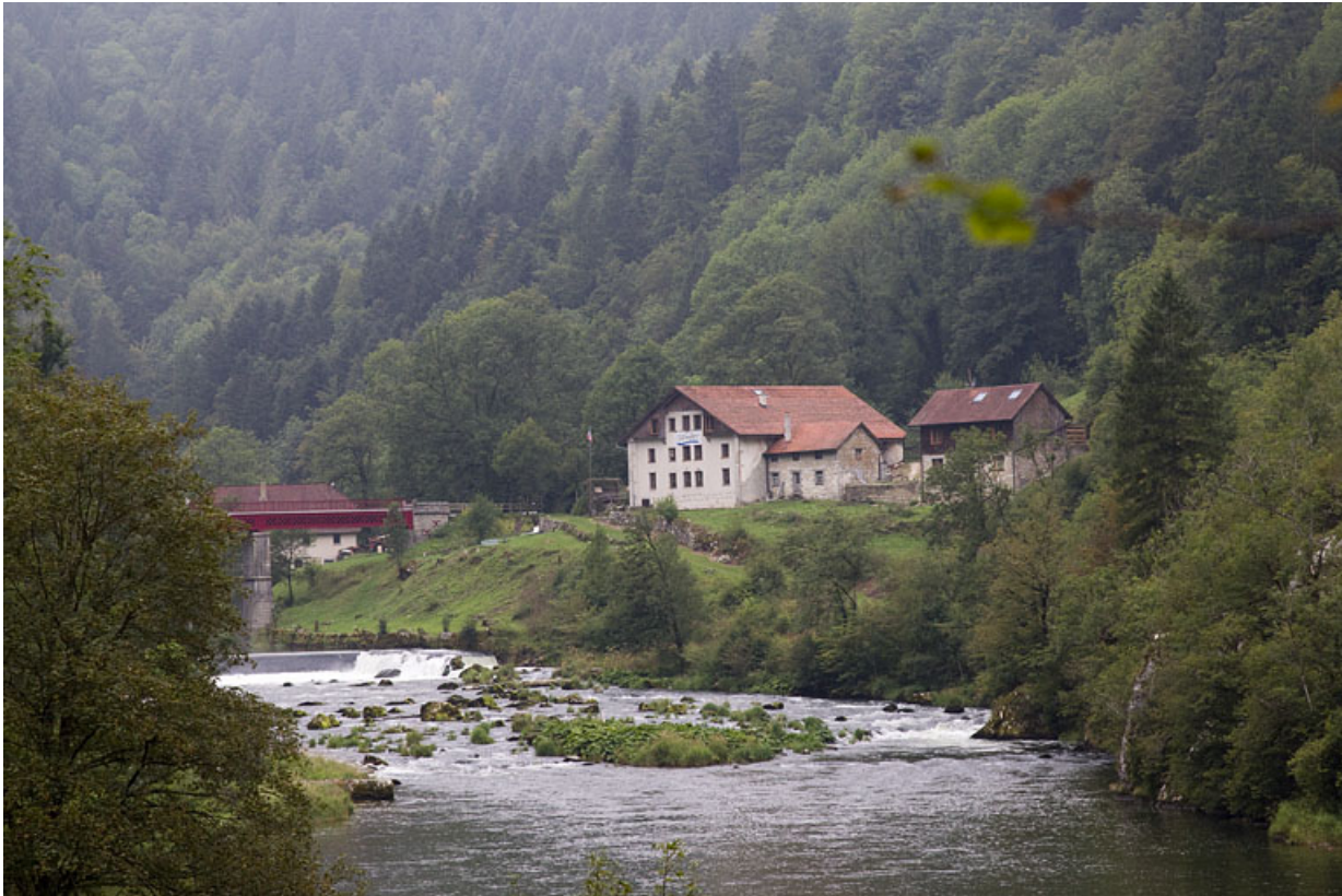
Vue d'ensemble du site depuis l'aval.
