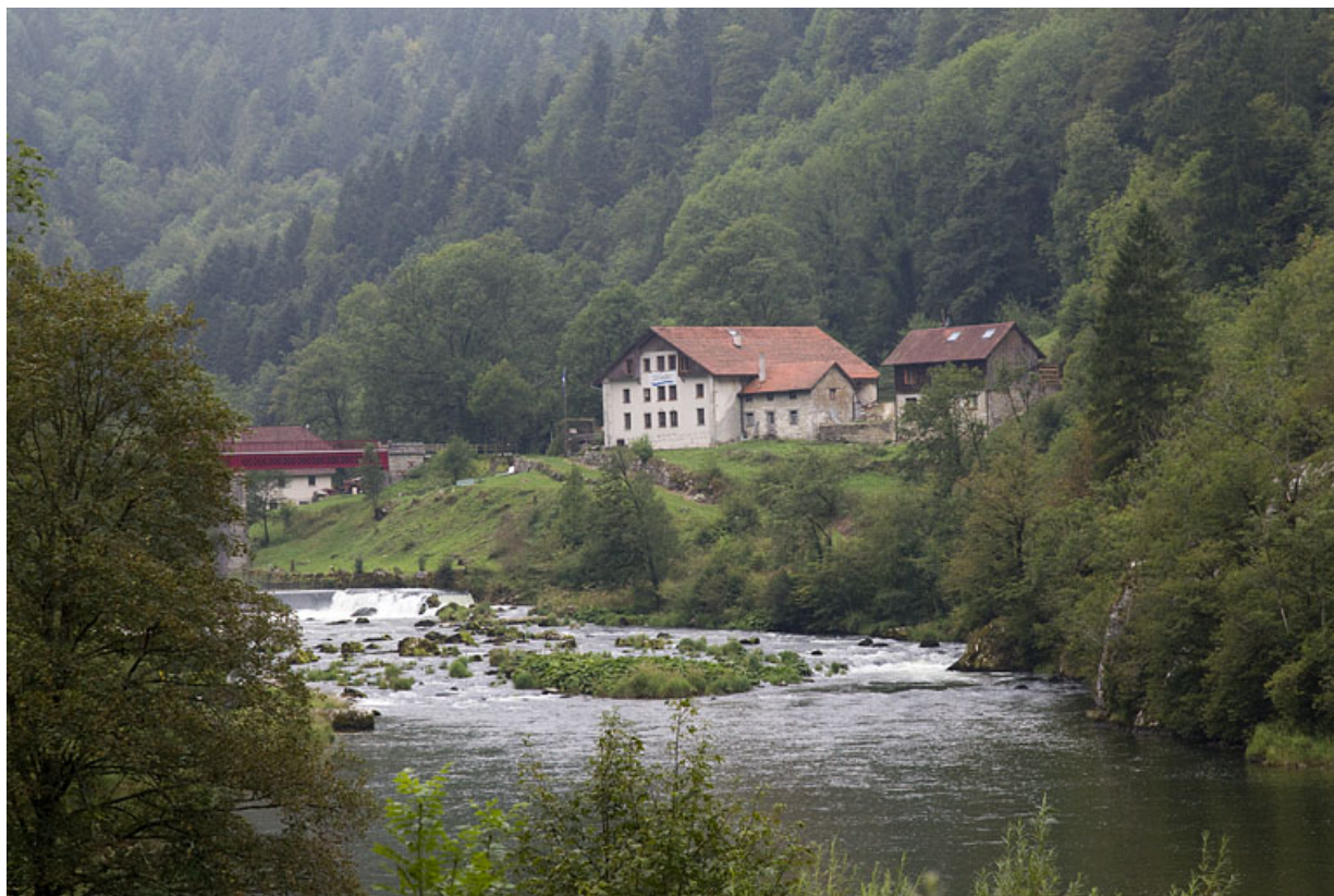
Vue d'ensemble du site depuis l'aval.
