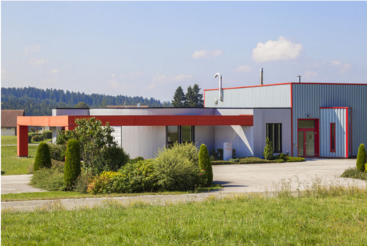
Façade antérieure : bureaux et entrée.
