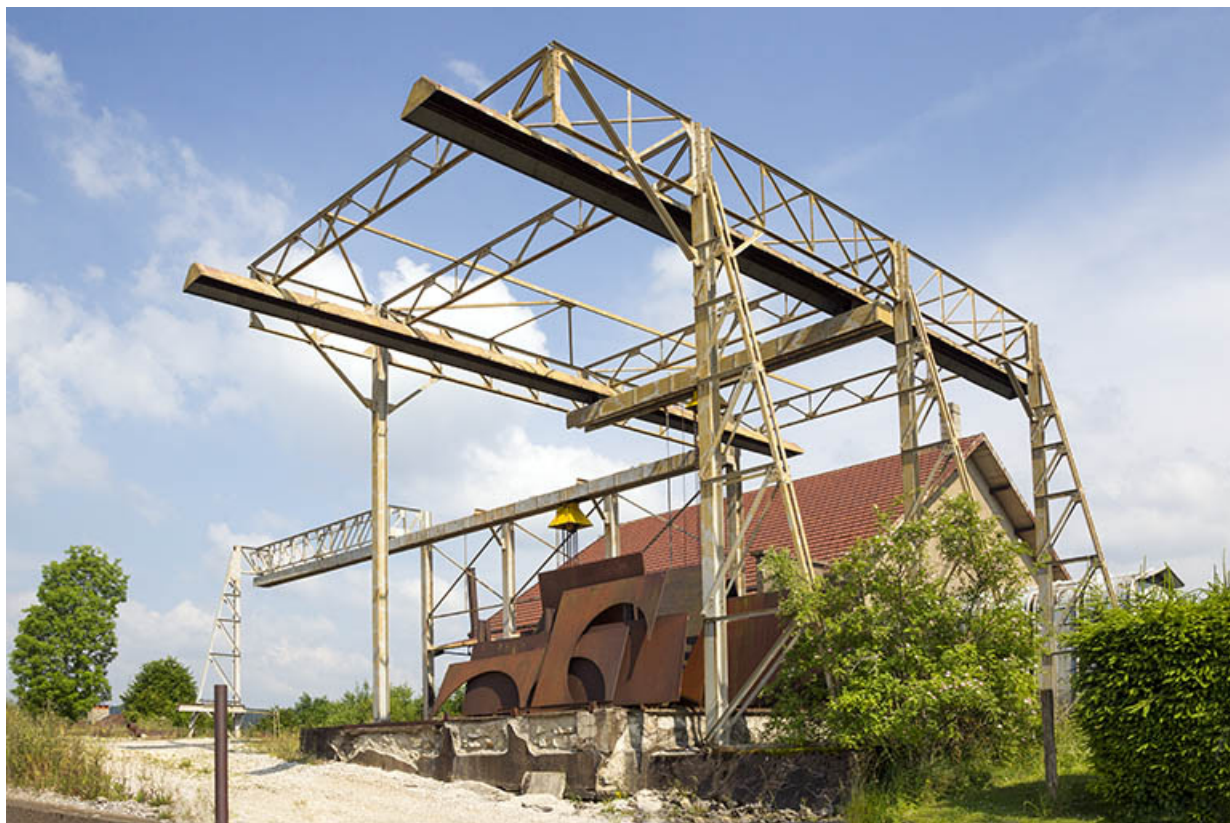
Site rue du Contremont : portique de manutention.
