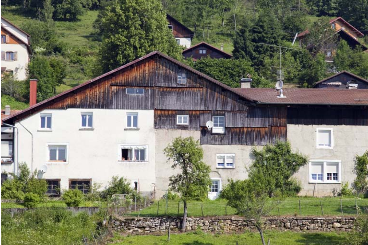
Façade latérale droite (vue rapprochée).
