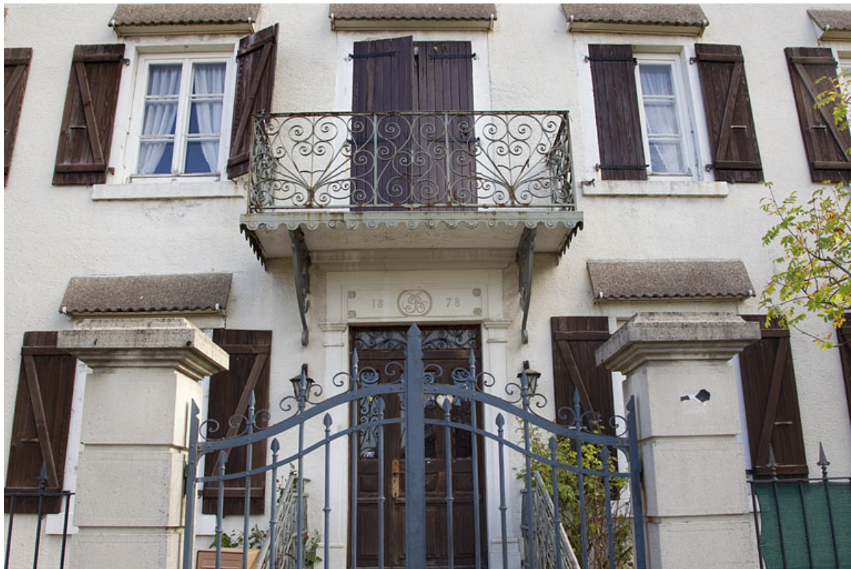
Logement patronal : porte d'entrée et balcon.
