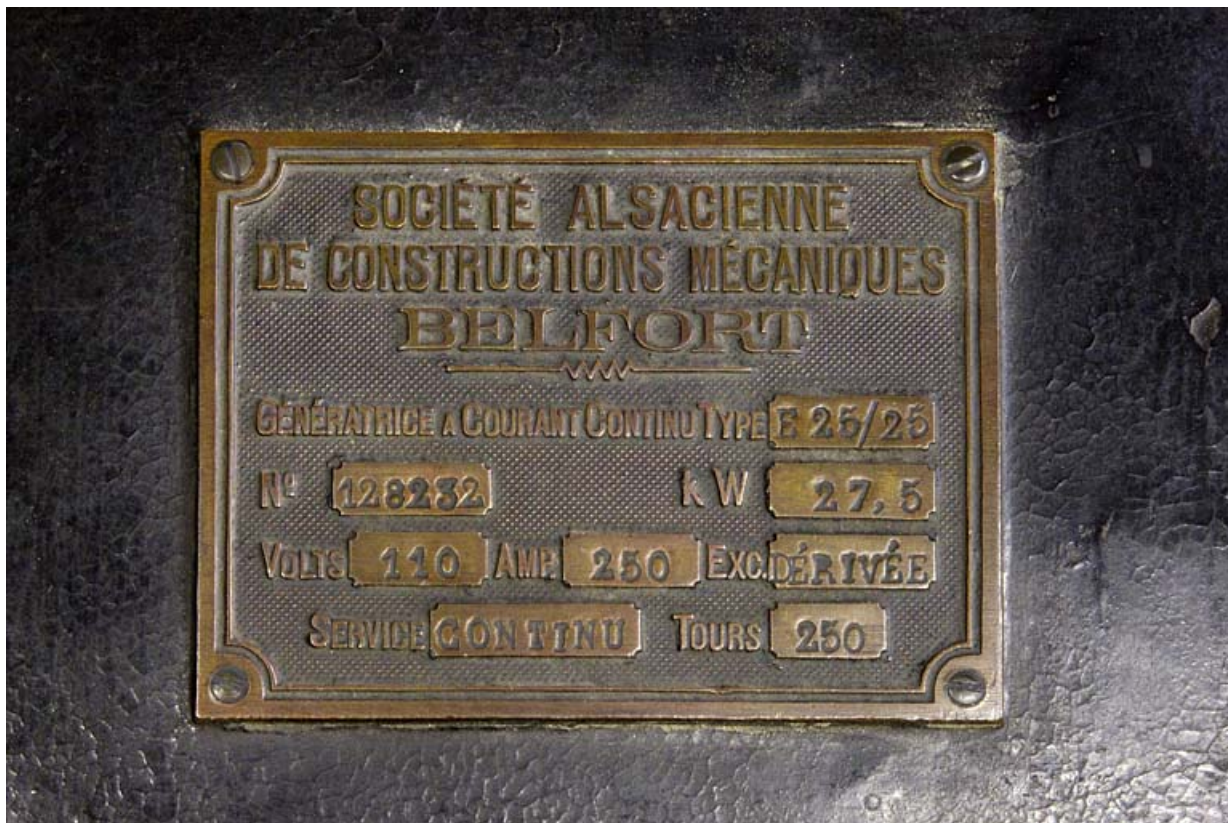
Centrale : plaque signalétique de l'excitatrice.
