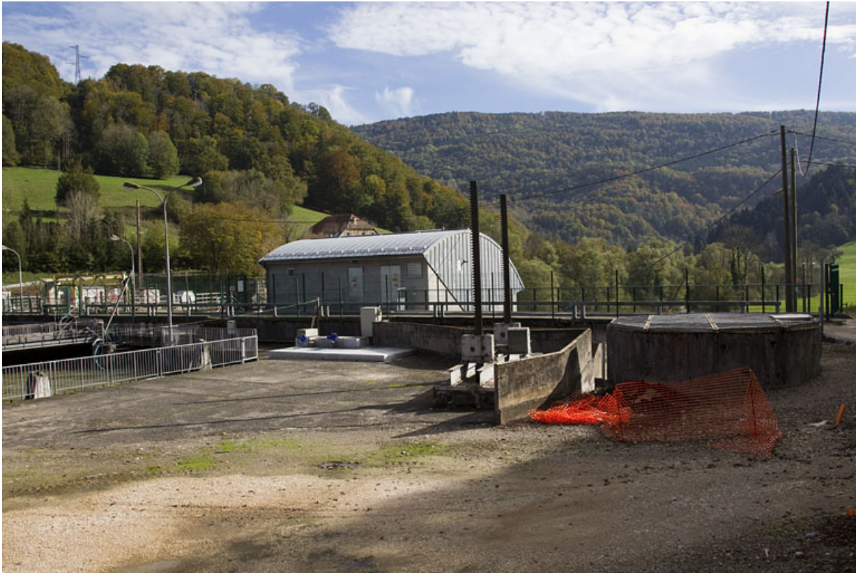
Prise d'eau : commande des vannes de protection.
