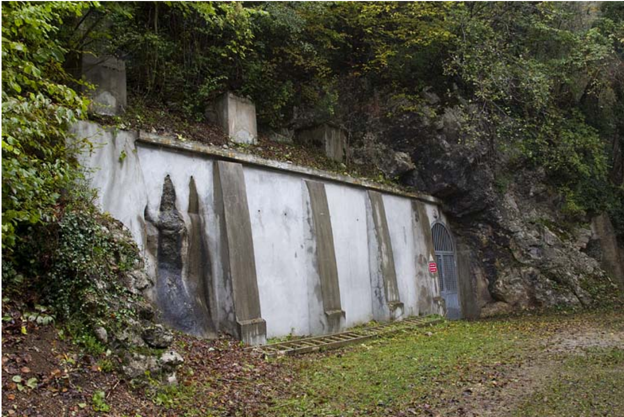
Tunnel d'amenée d'eau : tête aval.
