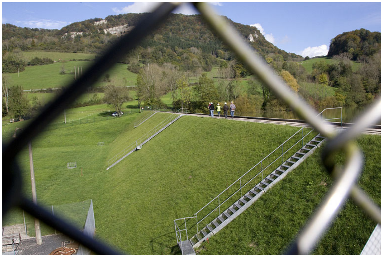
La digue depuis le barrage.
