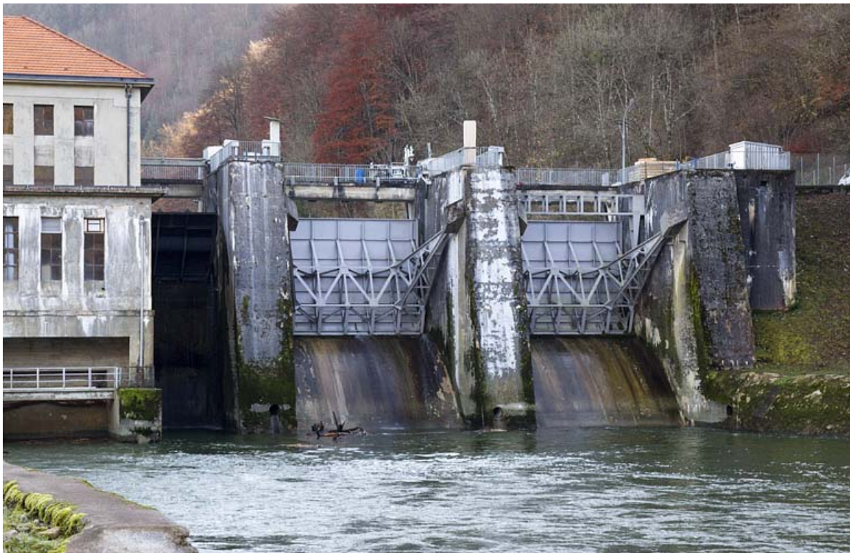
Le barrage vu de l'aval.
