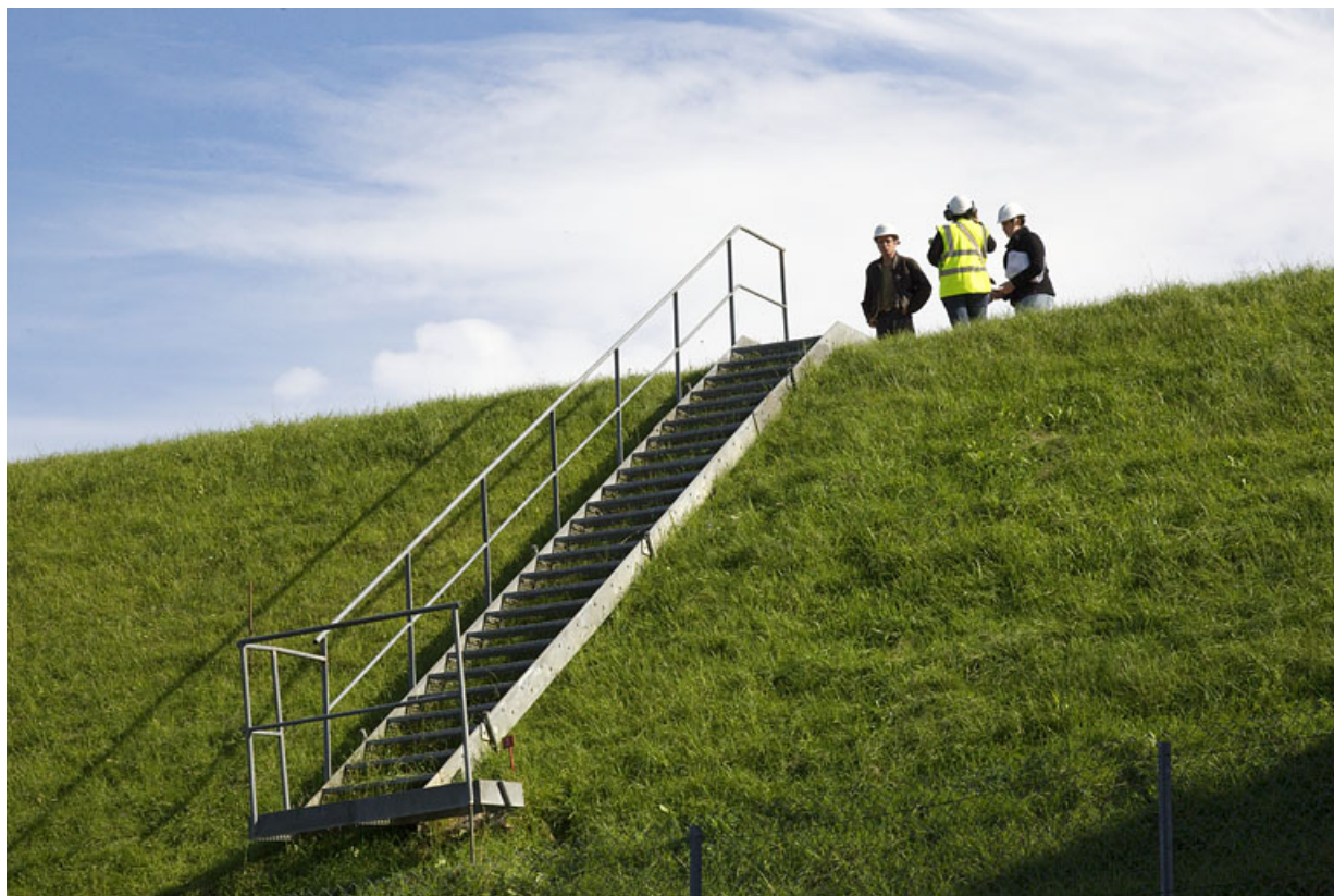
Digue : escalier menant à un puits piézométrique.
