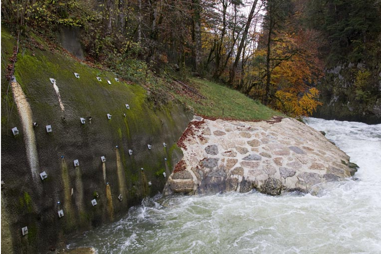
Berge renforcée en aval des vannes toit.
