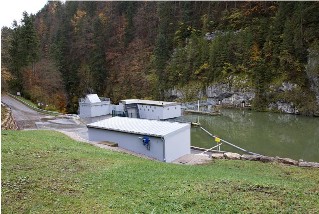
Vue d'ensemble depuis le nord-ouest (amont).
