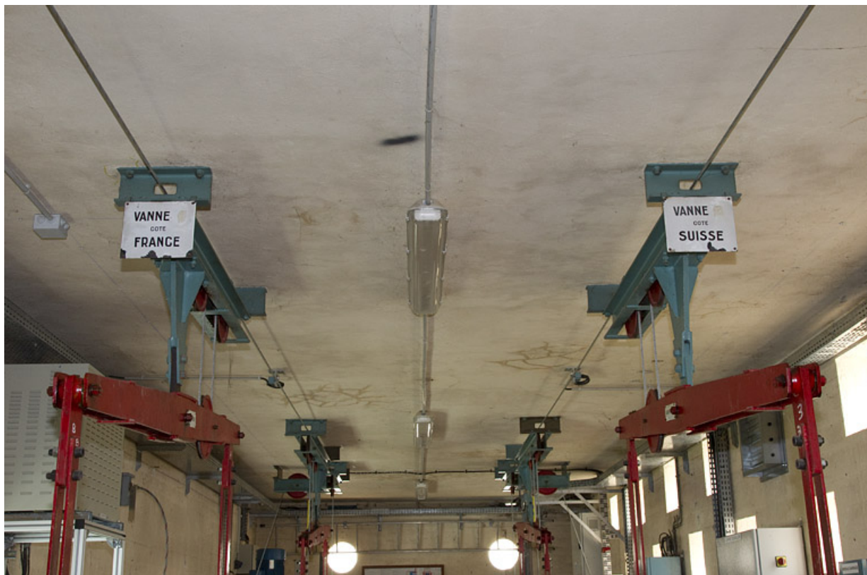
Barrage : repérage des vannes toit.
