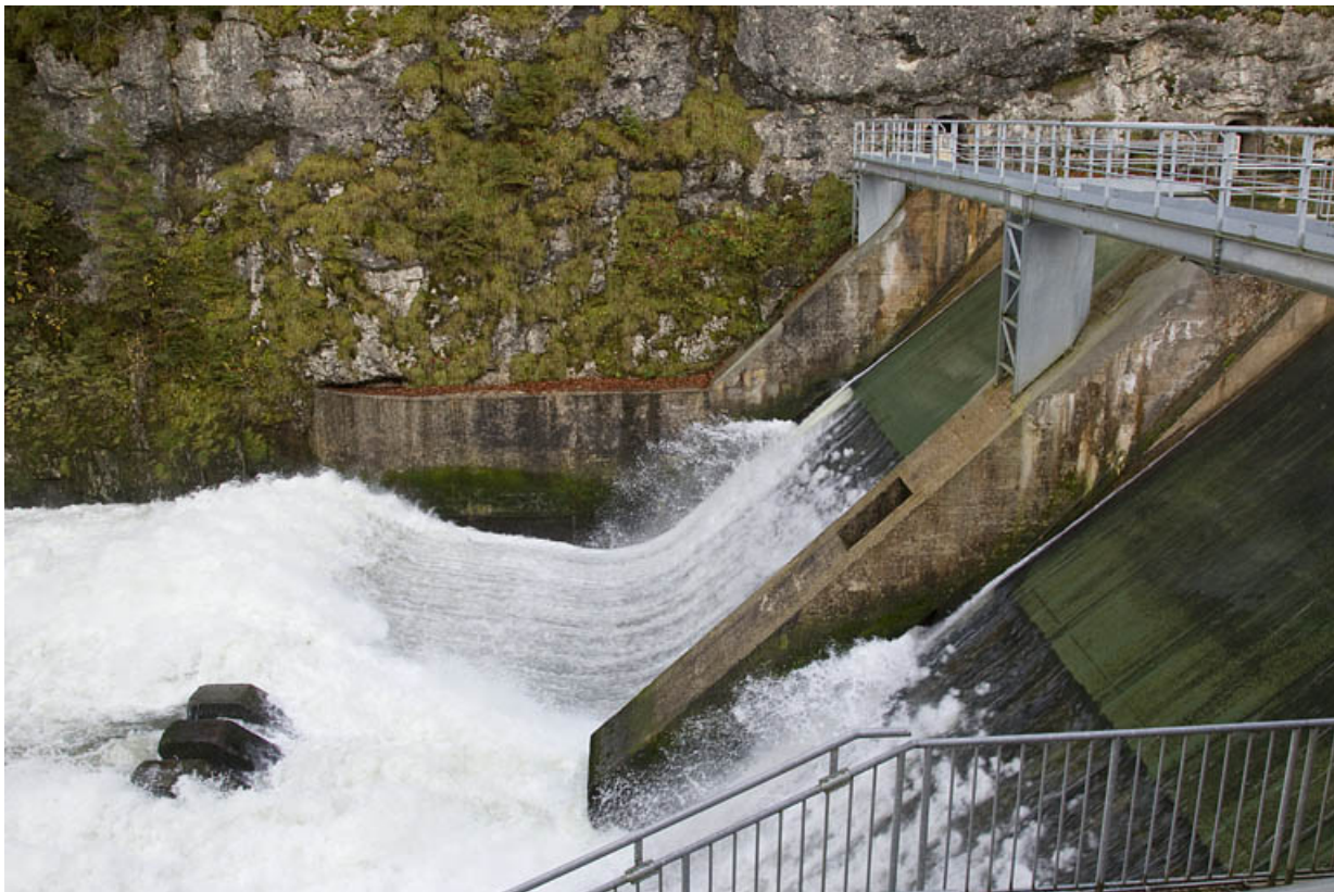
Barrage : vue plongeante sur les vannes toit.
