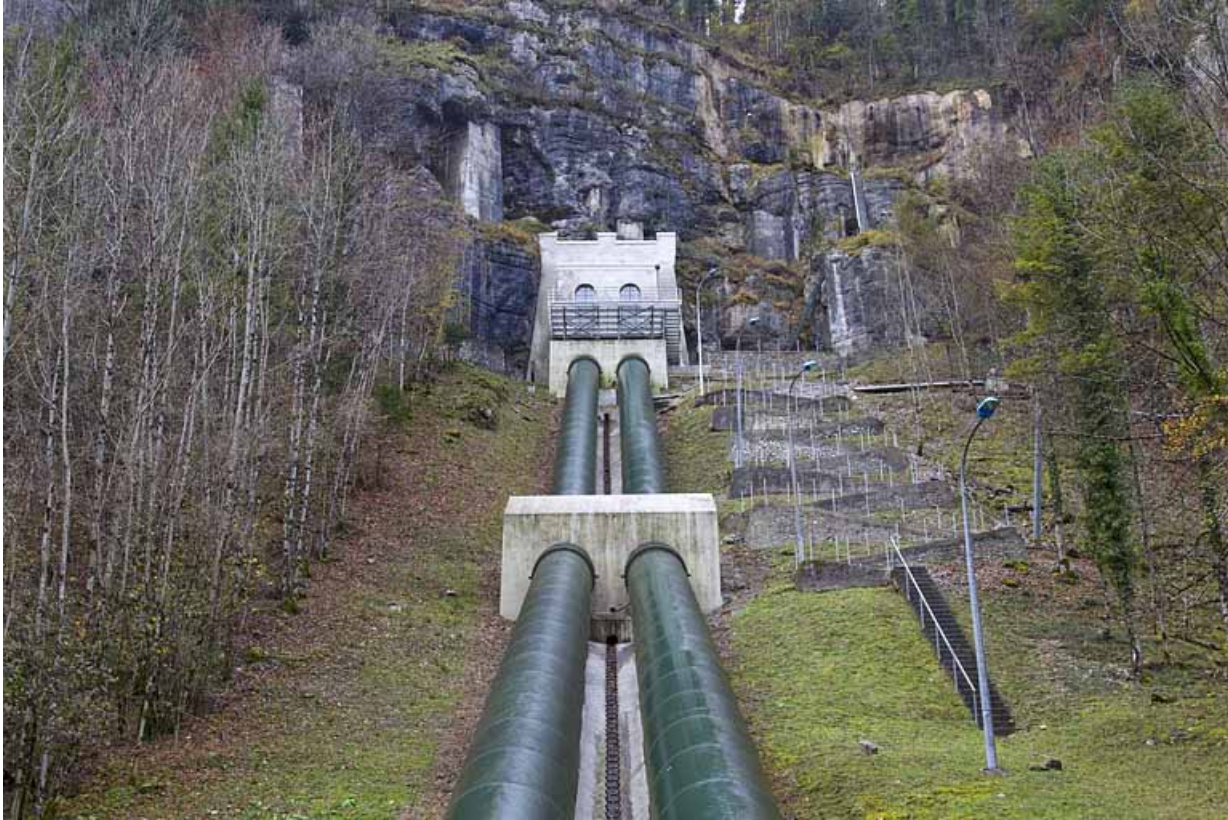
Conduite forcée : chambre de mise en charge et conduite, depuis la centrale.
