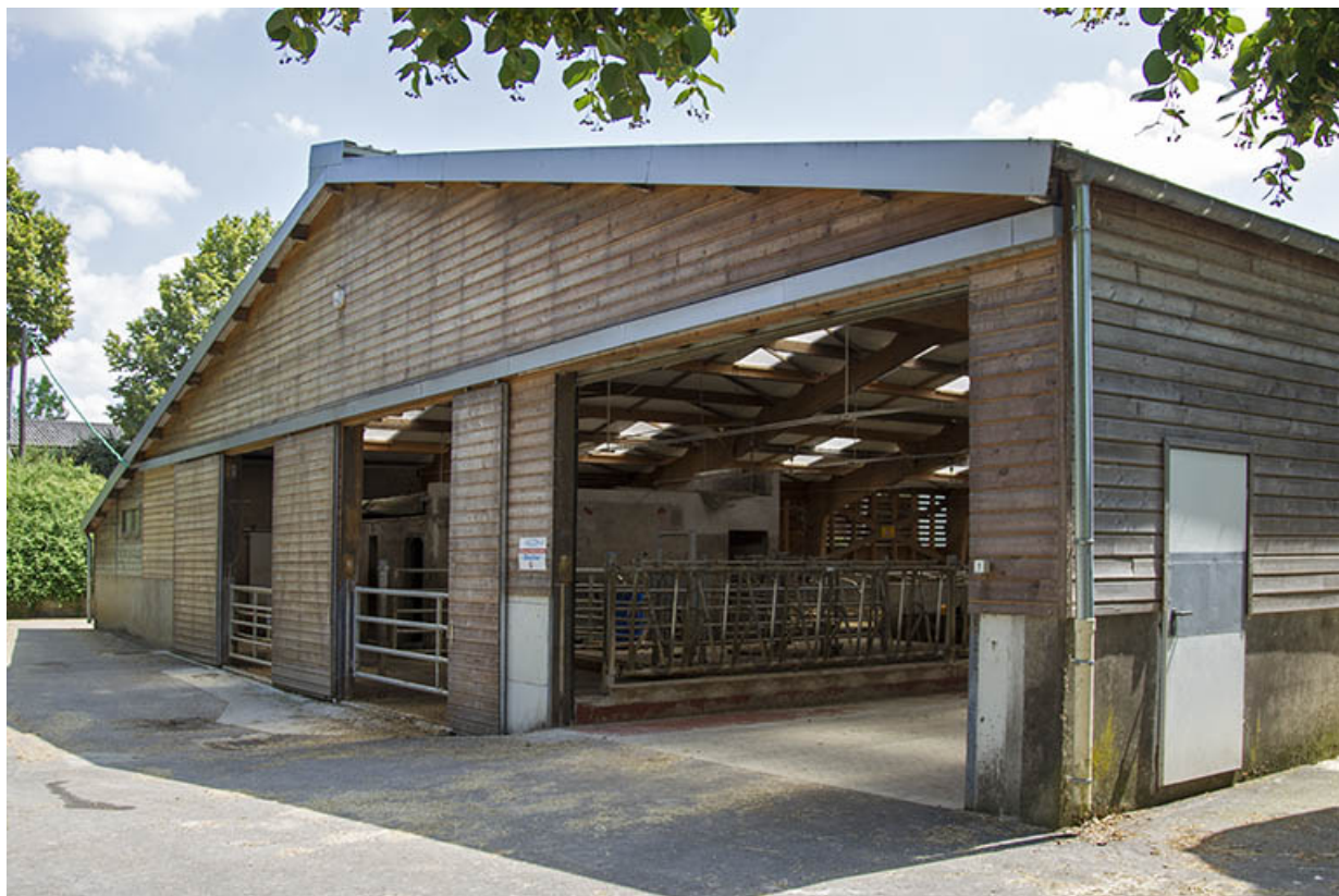
Pignon nord de l'étable ouest.
