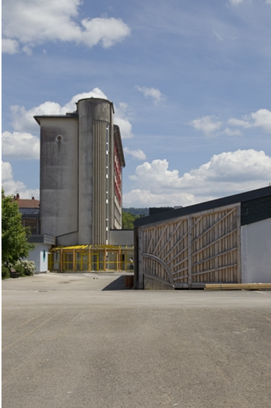
Internat garçons : face latérale et cage d'escalier.
