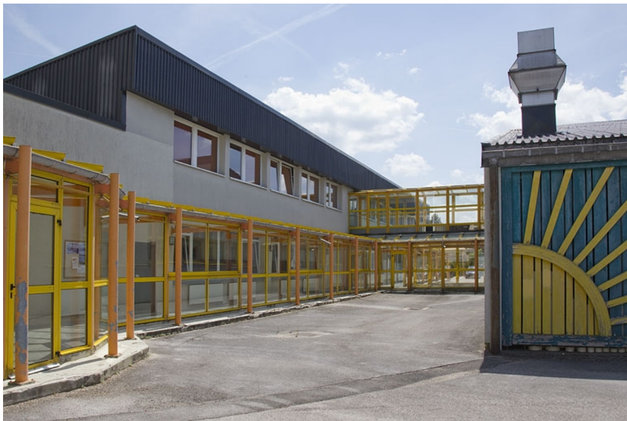
Galerie et atelier de maintenance et électrotechnique.
