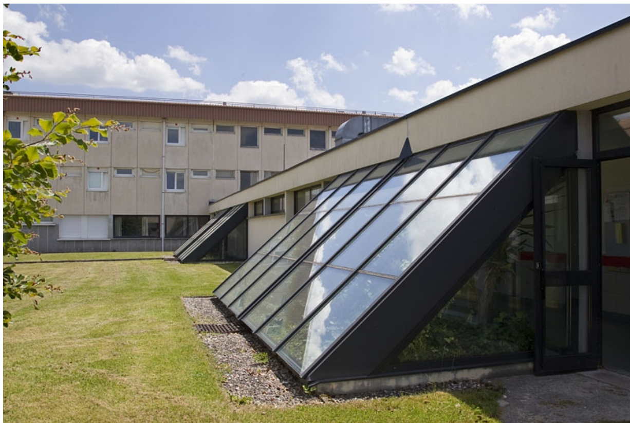
Bâtiment de la restauration : face nord.
