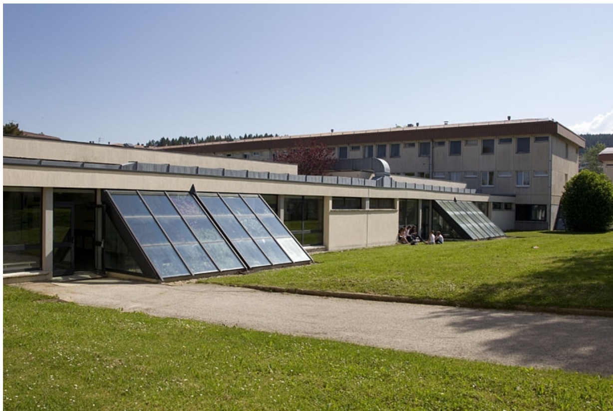
Bâtiment de la restauration : face sud.
