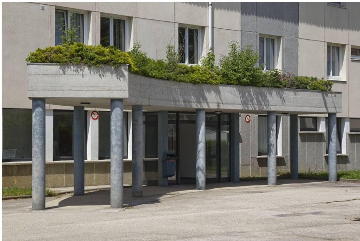
Bâtiment de l'infirmerie : portique.
