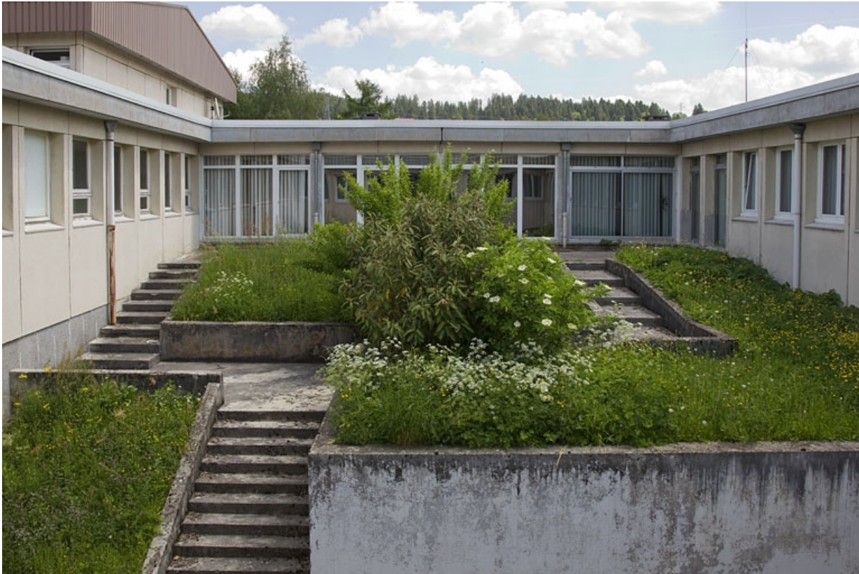
Bâtiment de l'administration : patio.
