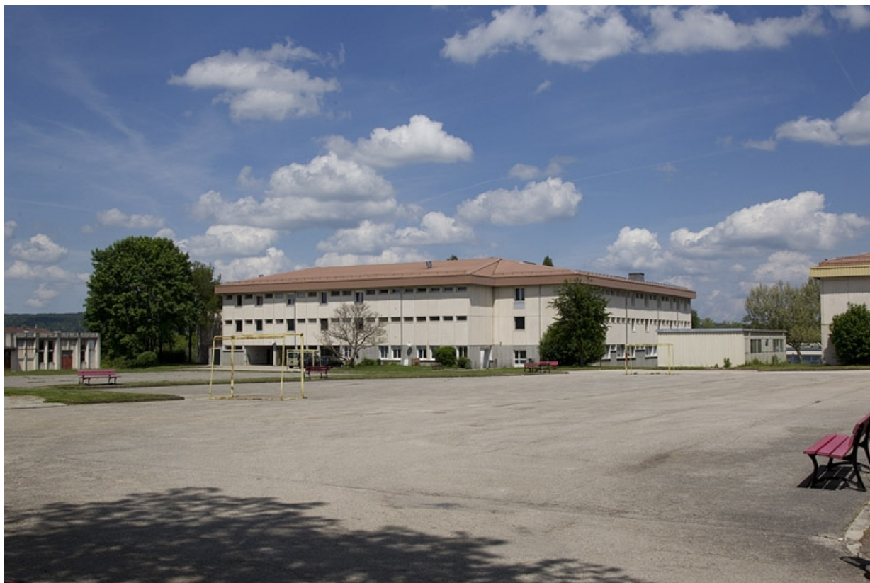
Bâtiment de l'internat ouest, vu du sud.
